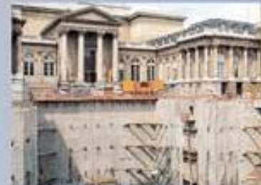
Assemblée Nationale : parking en construction, vue de la parcelle voisine, 1990.
