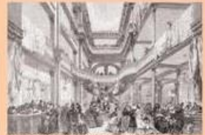
Vue des Marchés, le grand hall et le grand escalier A. Moisant réalise l'innovation métallique du premier magasin (1859-1872), G. Eiffel celle de l'arcade (1872-1874). Musée Cassandre © 77477
