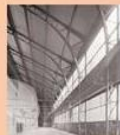
Intérieur du bâtiment 22 abritant l'industrie rouillière d'Étigny-Méroux. Fermes de type de Dion. © Direction Générale / Crédit : C. Dubois ADAGE
