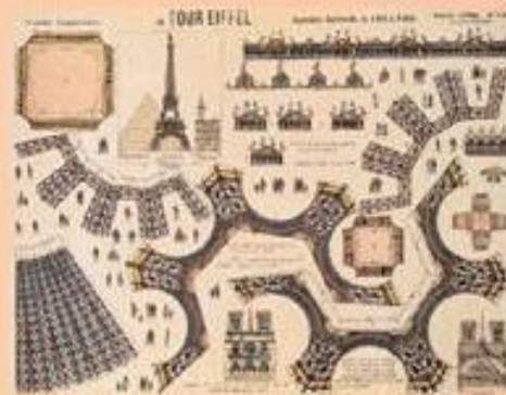
Exposition universelle de 1889 - Tour Eiffel, vue de construction, image d'Épinal. Musée d'Orsay, Fonds Eiffel, 014481 The 1889 World Fair - The Eiffel Tower, a building given to France.
