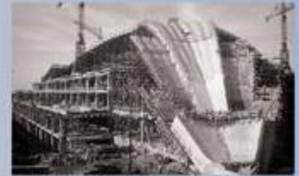
Détail du coffrage du 2 e niveau, après l'achèvement du 1 er niveau le 24 février 1955.
