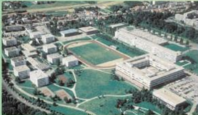
Le campus de l'Ecole Centrale à Châtenay-Malabry conçu par Jean Demuyn, François Viole, Jean Pignat, puis son successeur Michel Barberi, et Pierre Drouin. © D.S. / Direction de la Construction de l'Ecole Centrale The Centrale school campus built by Jean Demuyn, François Viole, Jean Pignat, then its successor Michel Barberi, et Pierre Drouin at Châtenay-Malabry.
