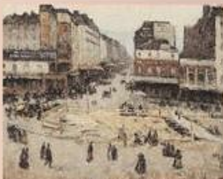
Travaux de Mitoyenneté en 1916, place Saint-Michel. Des ouvriers travaillent à l'entretien des trottoirs et des façades adjointes pour le matériel de la Seine avec les ouvriers Chabot et Cal, Y. Mérieux, 1916 Hôtel Carnot - Paris
