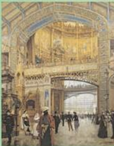
Le dôme central de la Galerie des Machines à l'Exposition universelle de 1889, œuvre de A. Moissas. L'exposition marqua le triomphe de la structure métallique dans E. Müller fut l'un des architectes les plus actifs. Musée Carnot The Great Dome of the Machine Gallery at the 1889 universal Exhibition, the work of A. Moissas. The exposition marked the triumph of the iron structure - in which E. Müller was one of the best French engineers.
