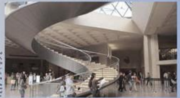
La structure de Dumas, sous la pyramide du Grand Louvre, est un modèle de béton de très bel aspect, qui réconcilie la comparaison avec la pierre. © J.-L. Bessis, 2004
