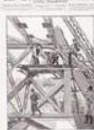
Les travaux de la Tour Eiffel. Le crâne à 50 mètres au-dessus du sol d'après nature par Louis Trogue, extrait de: Le Monde Illustré, 11 janvier 1888. Musée Carnot, © IMAF
