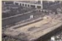
À la Bibliothèque François-Mitterrand, les travaux en sous-sol, impliqués sur 7 hectares, prennent en leur centre, une fosse étonnante de 25 m de profondeur située au bord du fleuve. Ces derniers créent un jardin et des salles de lecture sous la voûte de la Seine.
