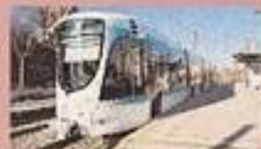
Léonore le tramway 2 - route Croix de la gare, à la station Les Croix de la gare, janvier 2017 © RATP - Photographie Expérimentale Parisienne / G. Berthoin Source: Les Croix de la gare, Les Croix de la gare, 2017
