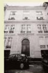
Ancien hôtel de la Société des ingénieurs civils, 15, rue Beugnot (1872). © J.-C. Duvoy, 2004. Former Home of the Civil Engineers Society, 15, rue Beugnot (1872).
