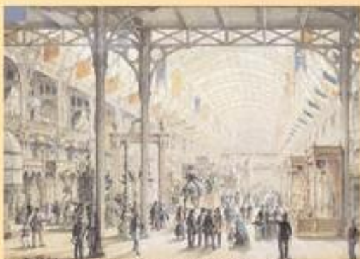
Le Palais de l'Industrie durant l'Exposition de 1855 par M. Bernheim. Sa charpente de fer, en forme d'arc, portée par des colonnes en fonte est l'œuvre d'Alexis Barrault et de Gustave Ebril. Musée Carnavalet © 2017 The Industry Palace during the 1855 World Fair by M. Bernheim. Its iron framework with shaped supports is one iron column by A. Barrault and G. Ebril's work.
