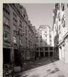
Façades sur le traitement des balcons des immeubles de rapport édifiés par E. Arnaud. Balcons, balustrades, frontons corinthiens et lucarnes finies à pentilles, sans symbole du style éclectique de l'architecte. Le Génie Civil, 27 janvier 1912.
