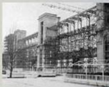
Les nouvelles tribunes en zones de construction, vers 1965, démontées à leur ripées au moyen de vérins hydrauliques et de câbles d'acier. © Florentin/Vinci Construction / Grand Prix The new grandstands under construction, in 1965, dismantled in the last minute using hydraulic jacks and cables.
