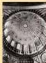
La coupole de l'église Saint-Augustin (1865). La structure de l'église est essentiellement métallique, la maçonnerie n'étant qu'un revêtement. Bibliothèque Perreyé
