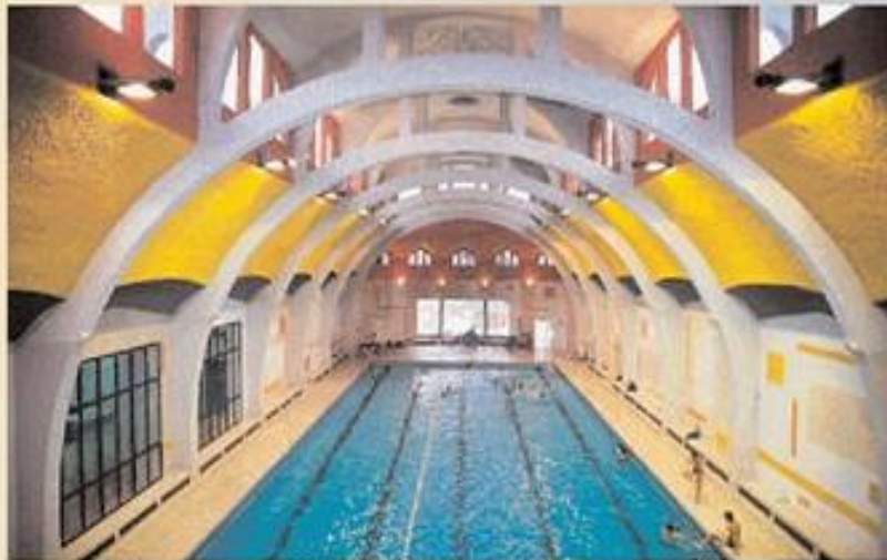
La piscine de la Seine-sur-Seine, 1924, architecte L. Dumas, entreprise Buffey-Monodique est un bel exemple d'affirmation de la structure.
