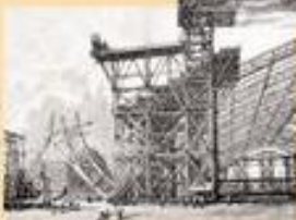
La construction de la Galerie des Machines. Le montage des fermes : mise au bœuf à l'un des piliers d'une ferme. 710, 1899. Musée Carnot, © 2010
