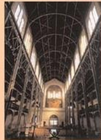
Église Notre-Dame du Travail, achevée en 1902. L'ossature en acier à Moisant-Laurent-Savey et C e .
