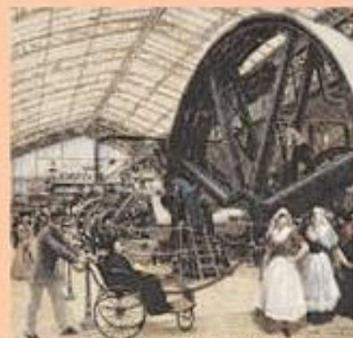
Exposition de 1889 : intérieur de la Galerie des Machines par L. Béroud. Dans l'immense nef de 429 m de long conçue par V. Contamin, des pinces radiales permettent aux visiteurs de contempler de haut le spectacle des machines.
