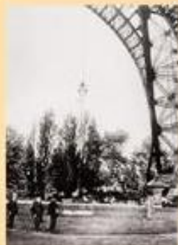
Eiffel teste la tour pour mesurer la résistance de l'air sur des surfaces géométriques guidées par un « appareil de chute » de sa conception, vers 1903-1904. © Coll. Laboratoire d'Aérodynamique Eiffel
