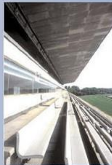
Les nouvelles tribunes vers les pistes. © J.-C. Dumez, 2006 The new grandstands, view toward the racetrack.
