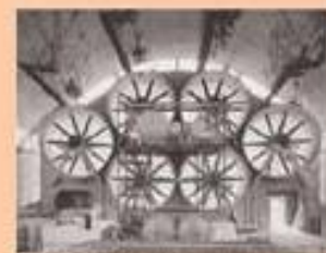
Les ribs de la grande soufflerie de Chalais-Meudon, qui inspire le système Eiffel. © Conservatoire Océanique, cliché P. Ayoub / ADA/SP The ribs of the Chalais-Meudon wind
